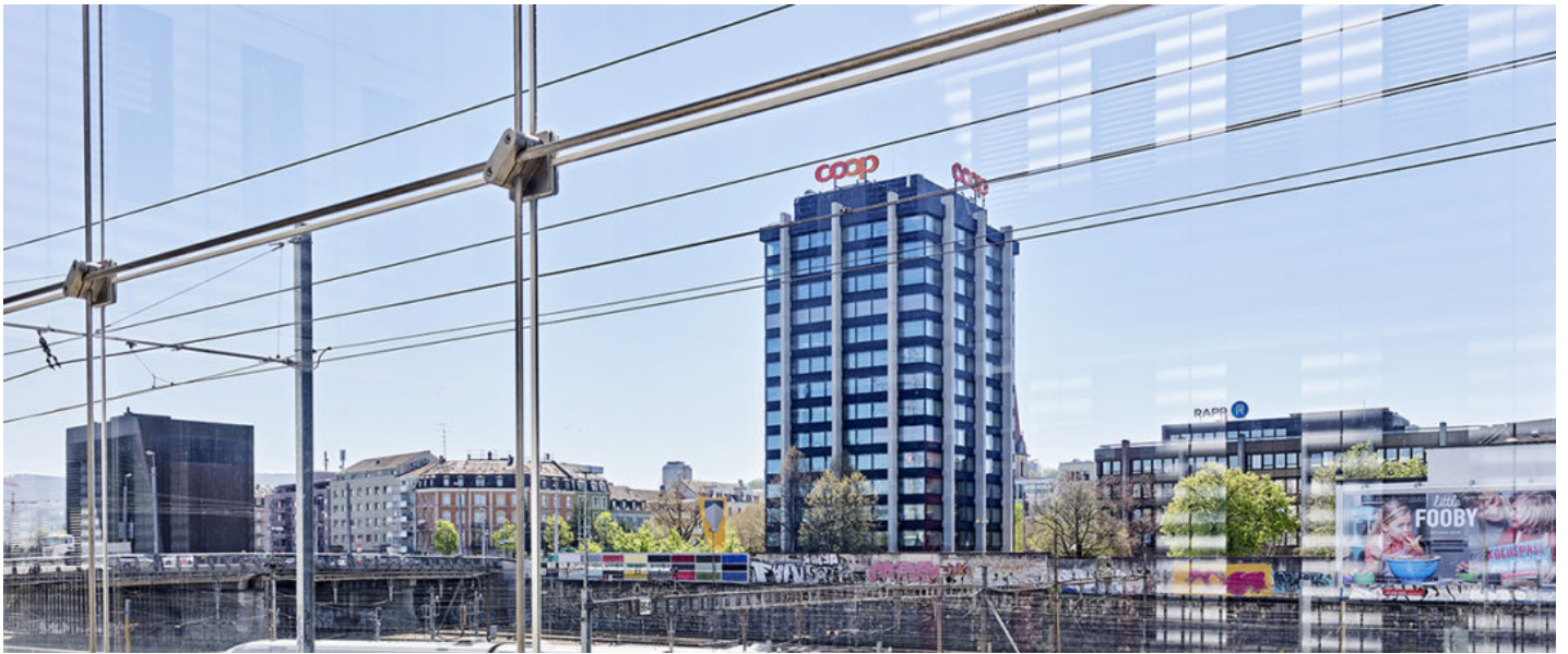
Sanierung Coop-Hauptsitz in Basel © Burckhardt+Partner AG / Mark Niedermann.
