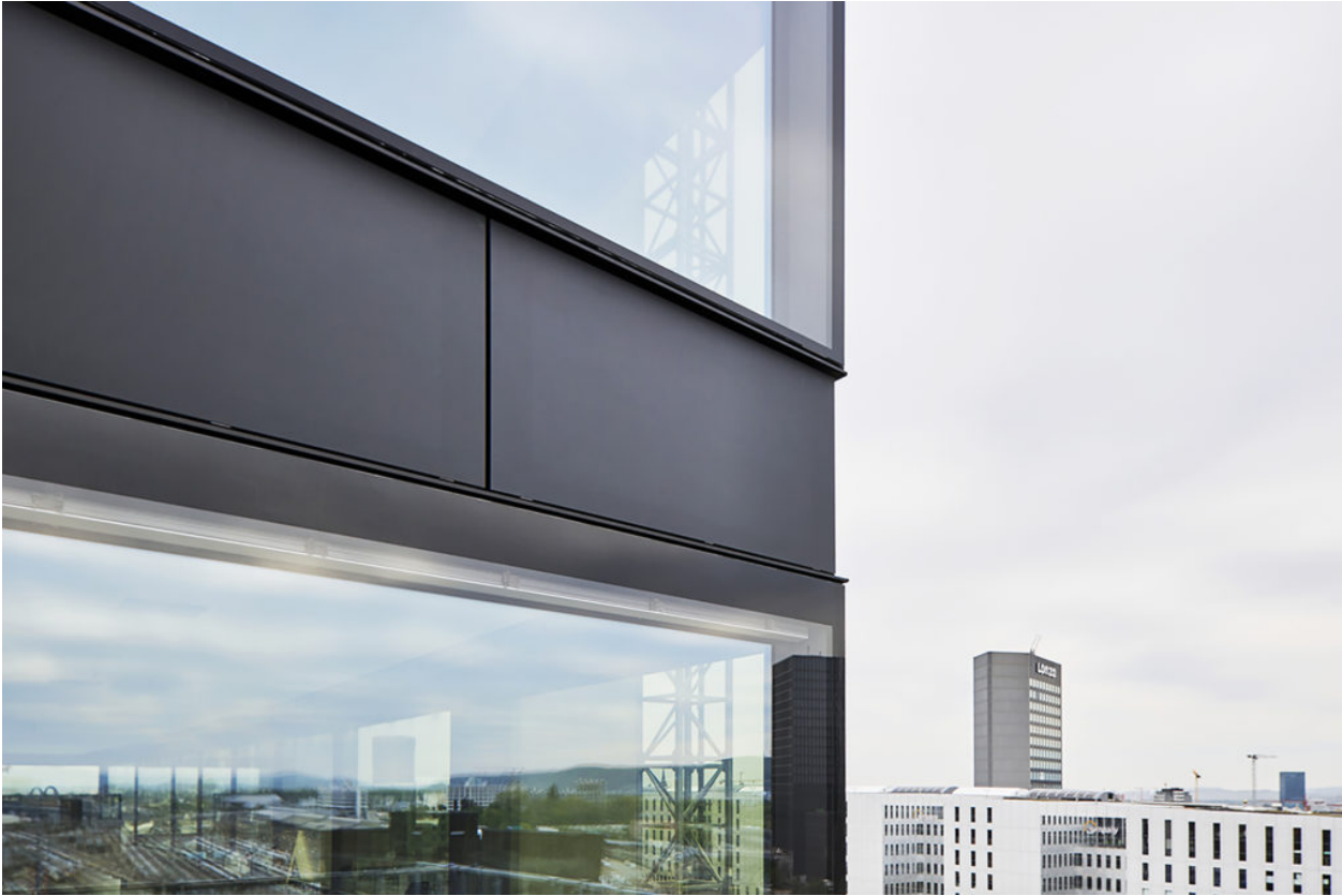
Dezent sind die Photovoltaik-Elemente in die Fassade integriert © Burckhardt+Partner AG / Mark Niedermann.
