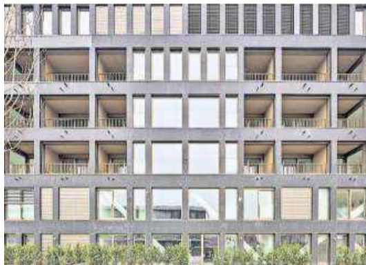
Das Gebäude steht mitten in Baden, darunter befindet sich der SBB-Tunnel.
