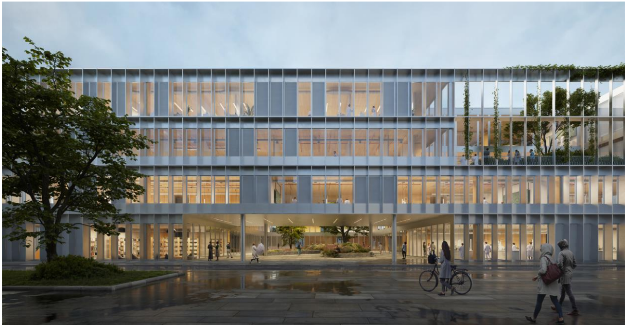
BU: So könnte das zukünftige Allgemeine Verfügungszentrum der Universität Bonn aussehen. Fünf naturwissenschaftliche Institute sollen dort untergebracht werden. © Visualisierung: Burckhardt+Partner / Play-Time
